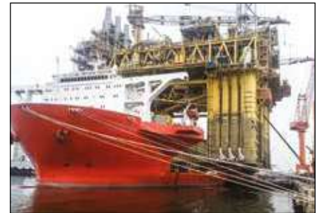
Монтаж і спуск на воду
