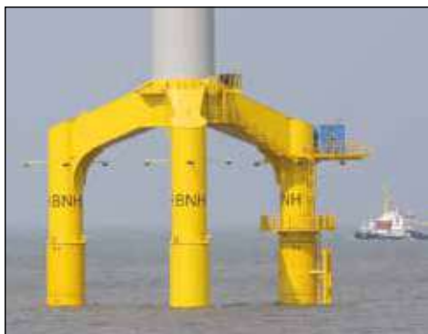
▲ Вирівнювання морських вітроустановок: Система синхронного піднімання Enerpac забезпечила вирівнювання опор 80 вітрогенераторів.
