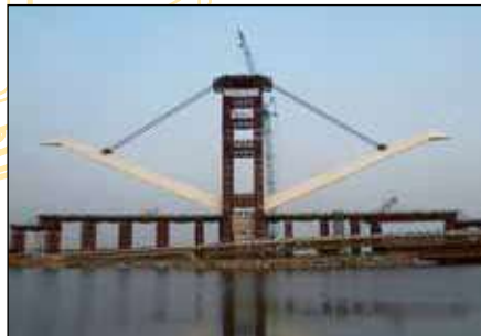
Високоточне піднімання важких конструкцій з використанням домкратів
