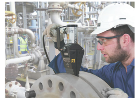
Equalizer SW15TE, який використовується в проекті з видалення втулки з трубопроводу
