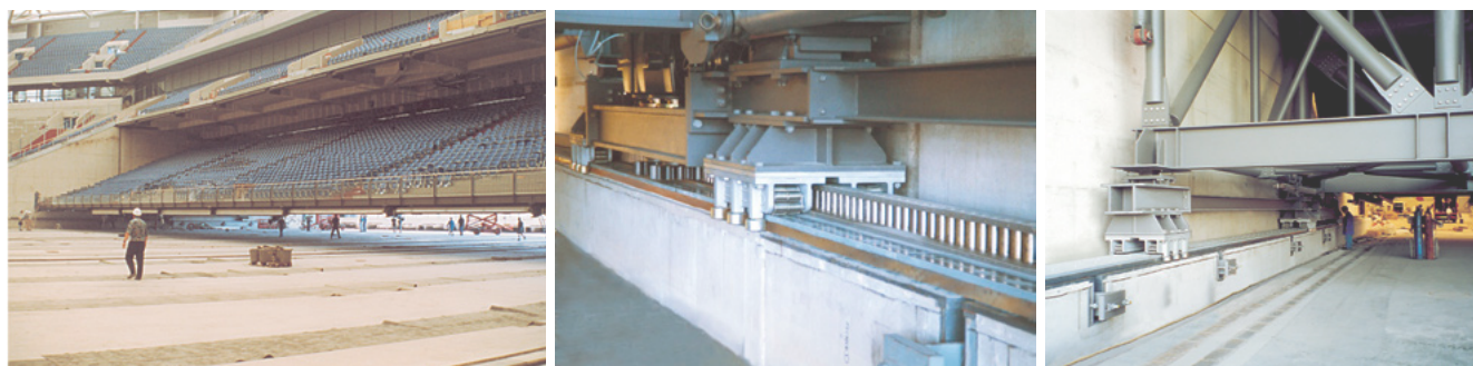
Переміщення трибун для глядачів на одному зі стадіонів, сумарною вагою в 800 тонн
